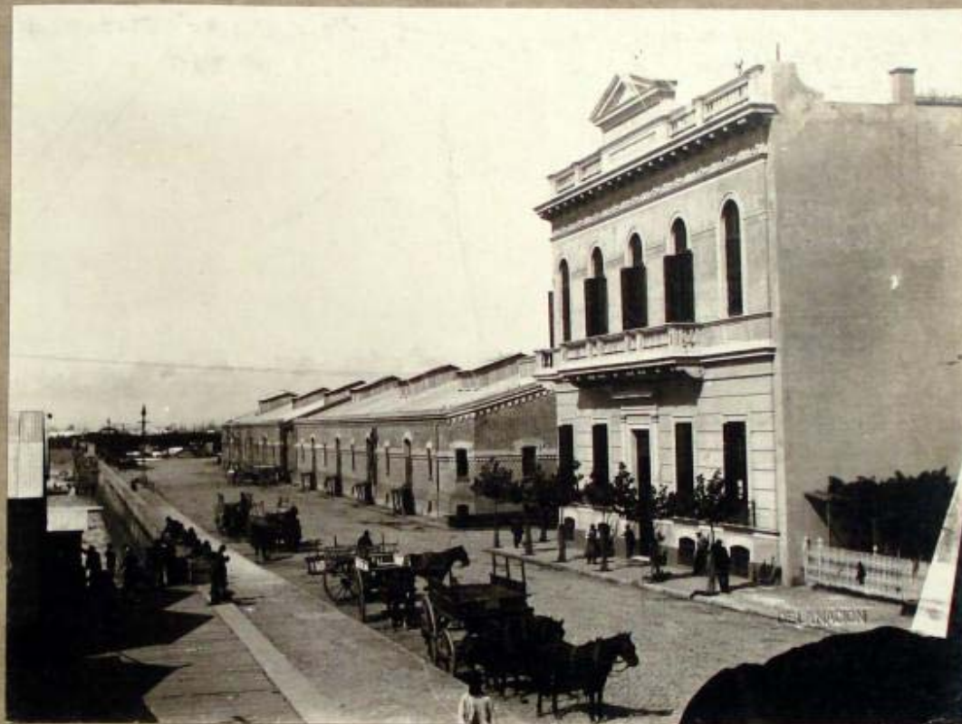
fs. 43 184-*Depósito de las Catalinas - Retiro
